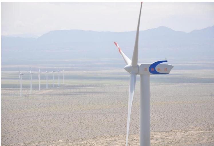
前端调速式2MW风电机组
